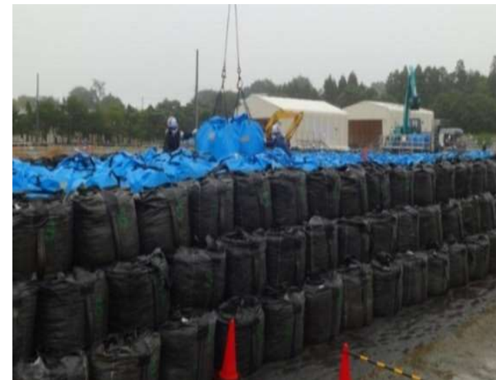
保管場への定置作業
