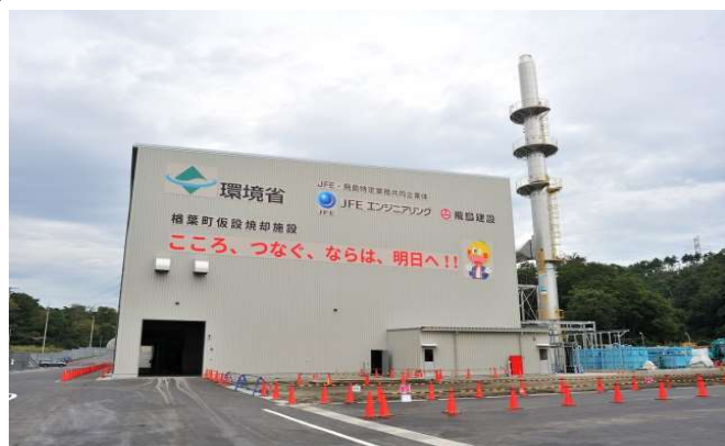
楢葉町の仮設焼却施設 (平成28年10月)
