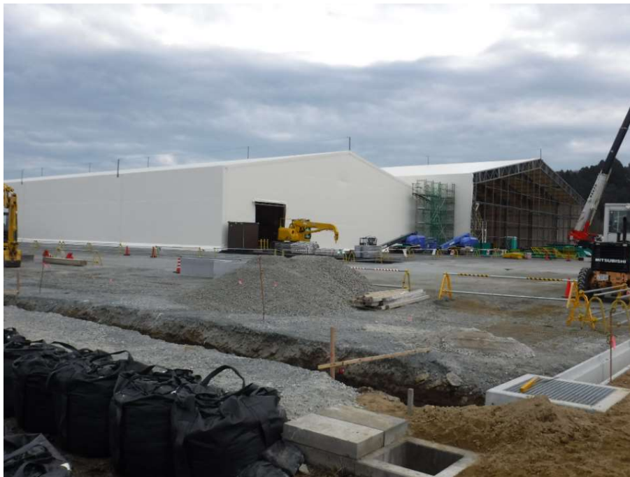
受入・分別施設の工事の状況
